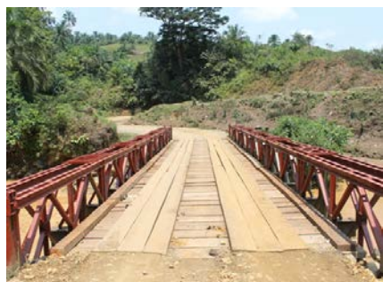
Pont Kadubo après réhabilitation
