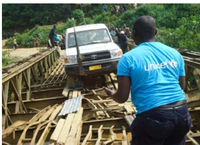
Pont Kadubo avant réhabilitation
